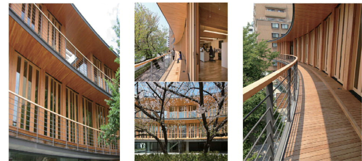
阳台·回廊地板和栏杆扶手采用了深层炭化处理的日本桧木，在满足耐久性能的同时给人以柔和的视觉享受。
