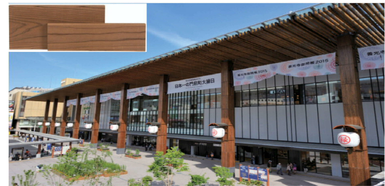
火车站（JR长野站）的吊顶、立柱使用了深层炭化处理·防腐处理日本柳杉材，既满足了长期耐久的性能要求又达到了木材装饰大型建筑物的视觉美观效果。
