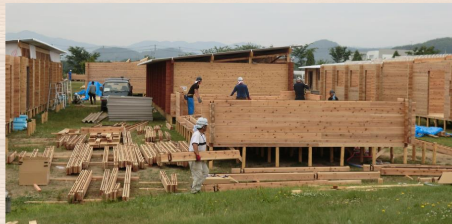
仮設ログ 建て方風景
